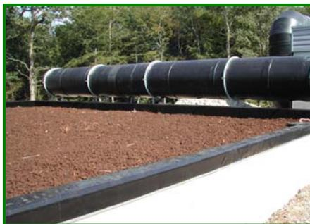
Compte tenu des caractéristiques des gaz à épurer, un lavage à l'acide est nécessaire pour l'élimination de l'ammoniac et des composés azotés. Les composés solubles seront éliminés simultanément. La biofiltration en guise de deuxième étape est une bonne solution pour la plupart des autres composés odorants présents dans le flux de gaz à traiter.
