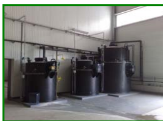
Geheel van opslagtanks voor reagenten
