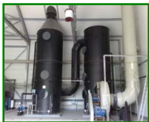
2 Gaswassers in serie met vullingsmateriaal
